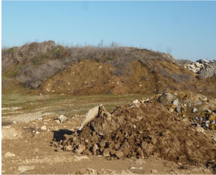
Prise de vue 12 : Un tas de terre végétale, destinée à recouvrir les surfaces régaliées, est stocké sur le site.
