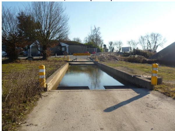
Prise de vue 14 : Sortie du site avec un dispositif de lavage de roues (utilisé principalement en hiver) pour ne pas salir la route.
