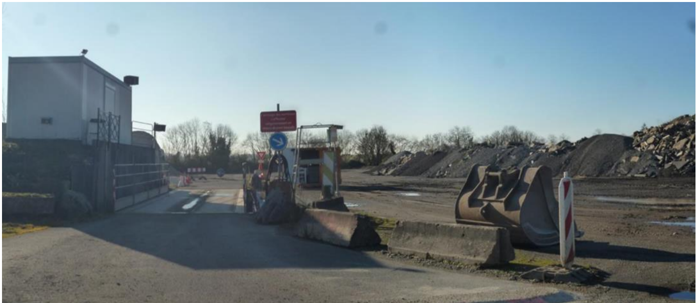
Prise de vue 5 : Pont bascule et local du responsable du site, en hauteur pour voir le chargement des camions.
