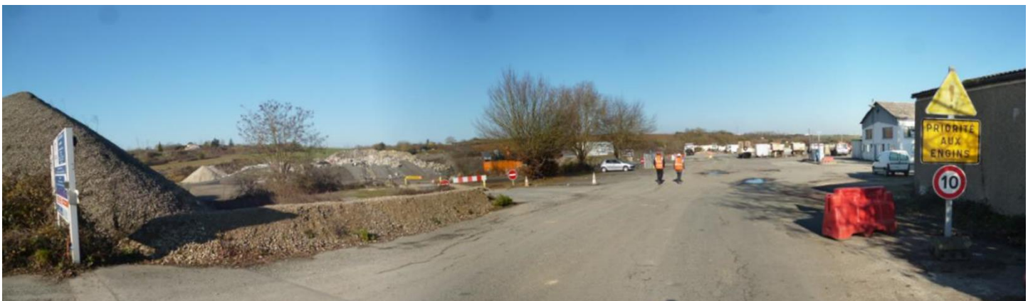
Prise de vue 3 : Panorama de l'entrée sur le site d'Eurovia.
