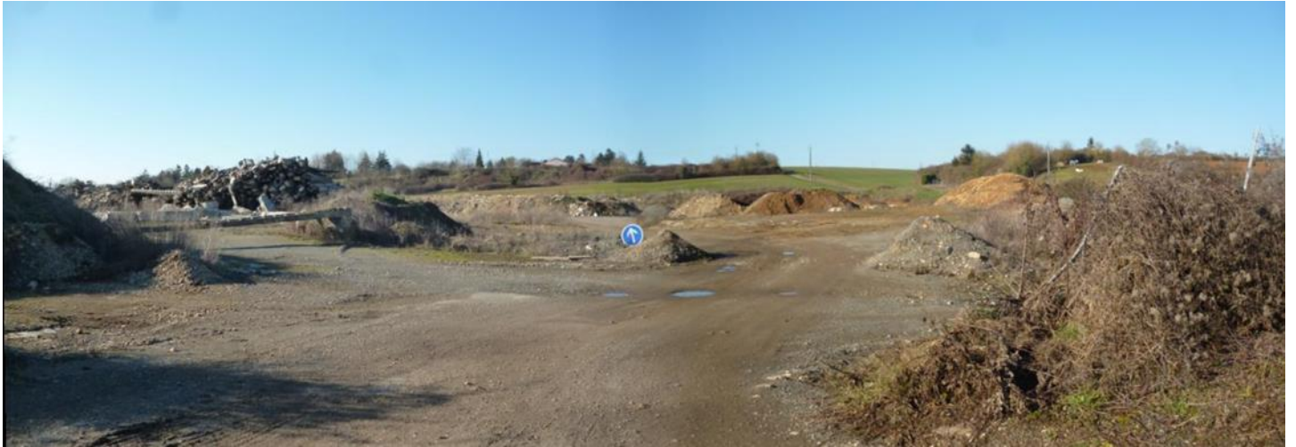
Prise de vue 6 : Panorama au niveau de l'entrée sur le site de l'ISDI (fin de la plate-forme de valorisation).
